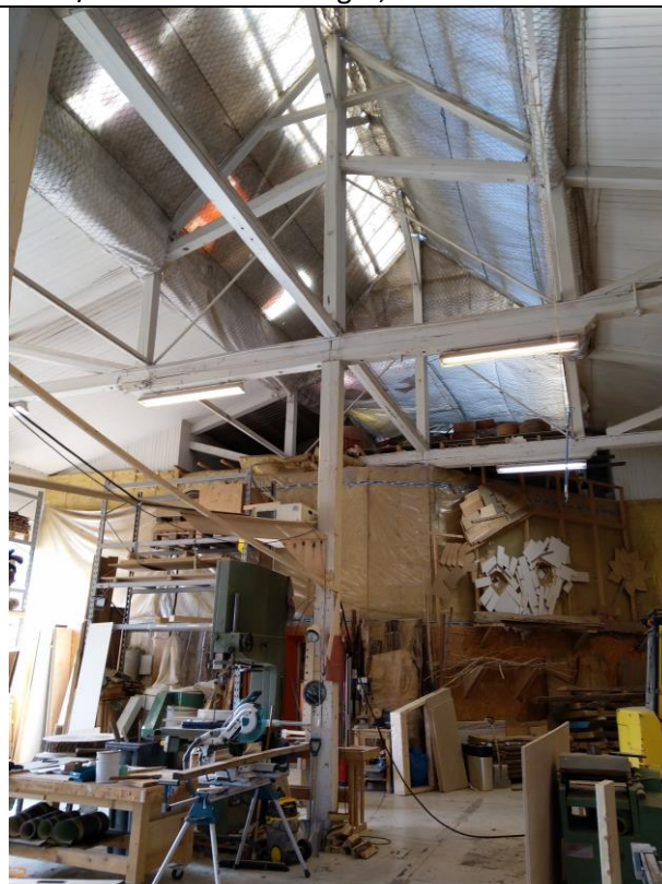
261-2: Takstol understøttet med søyle, rom S6-1101.
