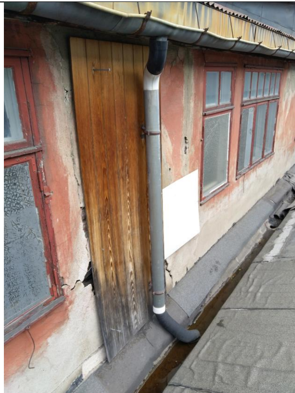
231-2: Yttervegg tredje etasje seksjon 1.
