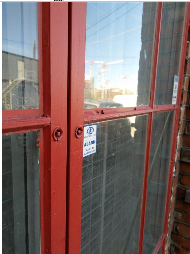
233: Glassfasade, fasade nord 1.
