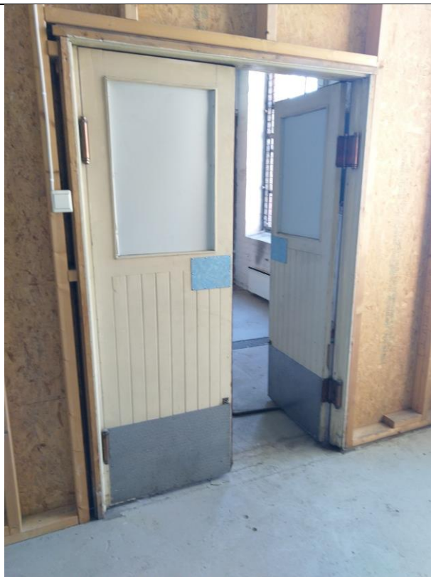
244: Innvendig vinduer, dører og foldevegger, rom S4-1103.
