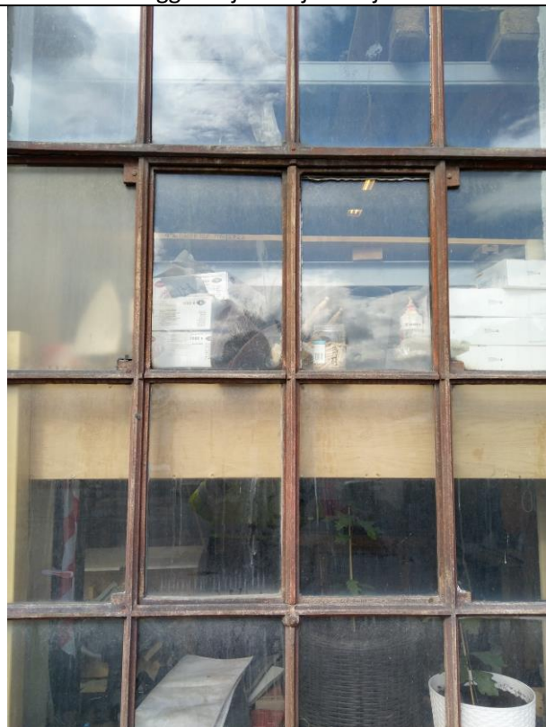
234-1: Støpejernsvinduer, fasade øst 1.
