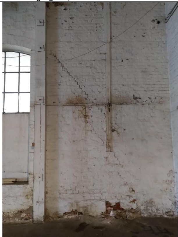
236.1: Innvendig overflate, rom S3-1301 vegg mot S4.
