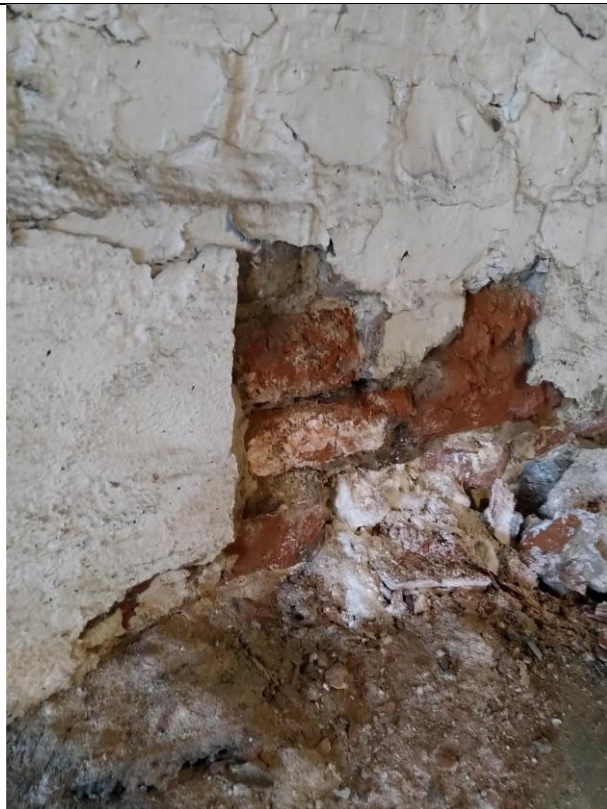
236.2: Detalj innvendig overflate, rom S3-1301 utsnitt av 236.1.
