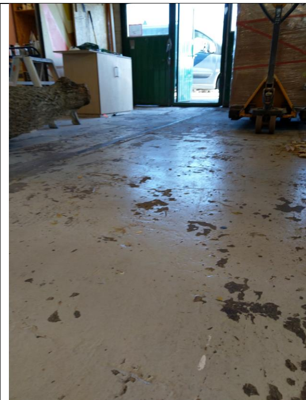
252: Gulv på grunn, støpt dekke, rom S6-1101.
