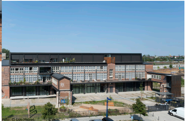
Til venstre: Vinduene har blitt restaurert, og det er et nytt lag med vinduer på innsiden, med god isolasjonsevne.
