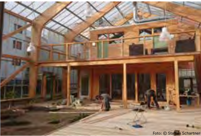
Over: Siste hånd på verket på et av felleshusene. I området er det også en barnehage, en omsorgsbolig, en skole og syv felleshus – ett for hvert kvartal.
