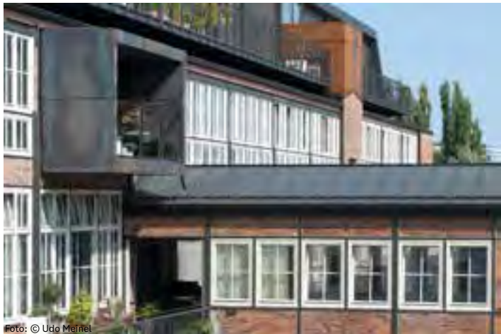
Til venstre: Vinduene har blitt restaurert, og det er et nytt lag med vinduer på innsiden, med god isolasjonsevne.
