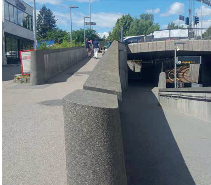
Vestsiden av t-banesporet mot Smestadkrysset. Her deler gående og syklende areal.
