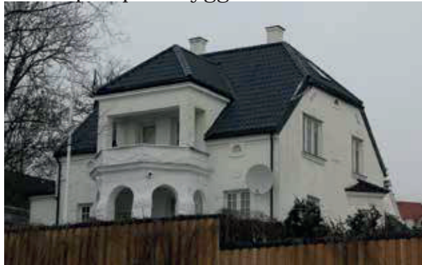
1. Munkengveien 2B, villa Munkhaugen fra 1906 arkitekt/byggherre Sigurd R. Gulbransen
