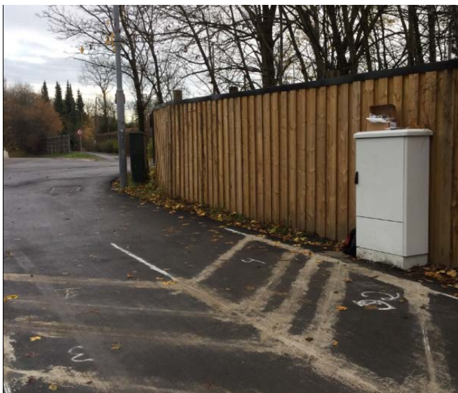
Figur 16 Registreringspunkt Smestad, tellesløyfer ligger i asfalten (Foto: Statens vegvesen).
