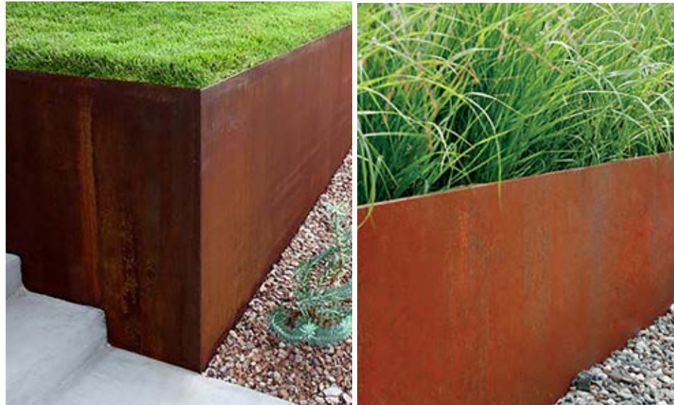
Kombinasjon av cortenstål og gress. (Kilde: pinterest.com)
