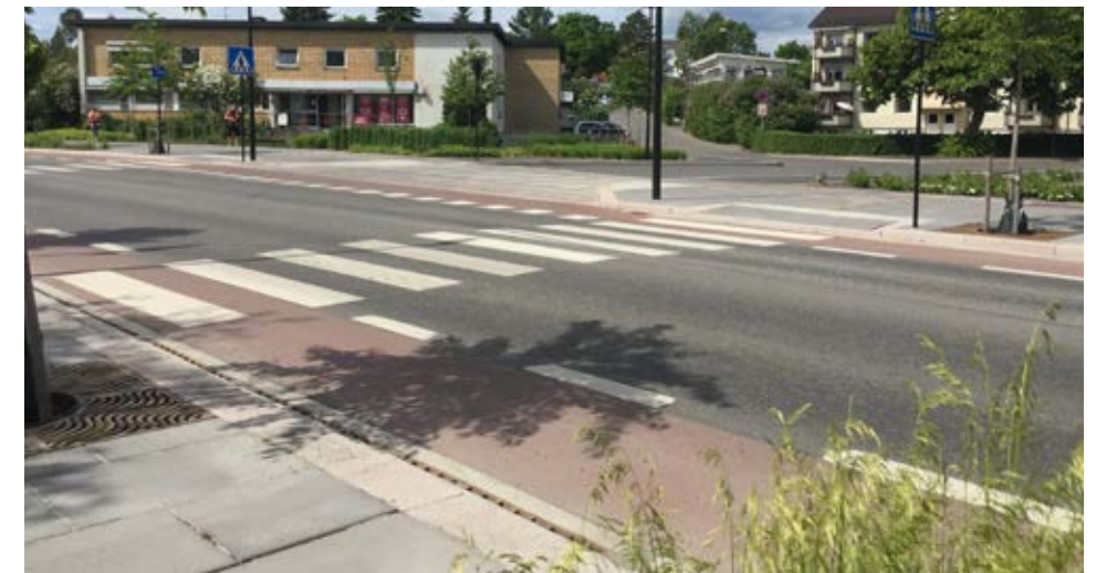
Gangfelt i Vangveien, Hamar.
