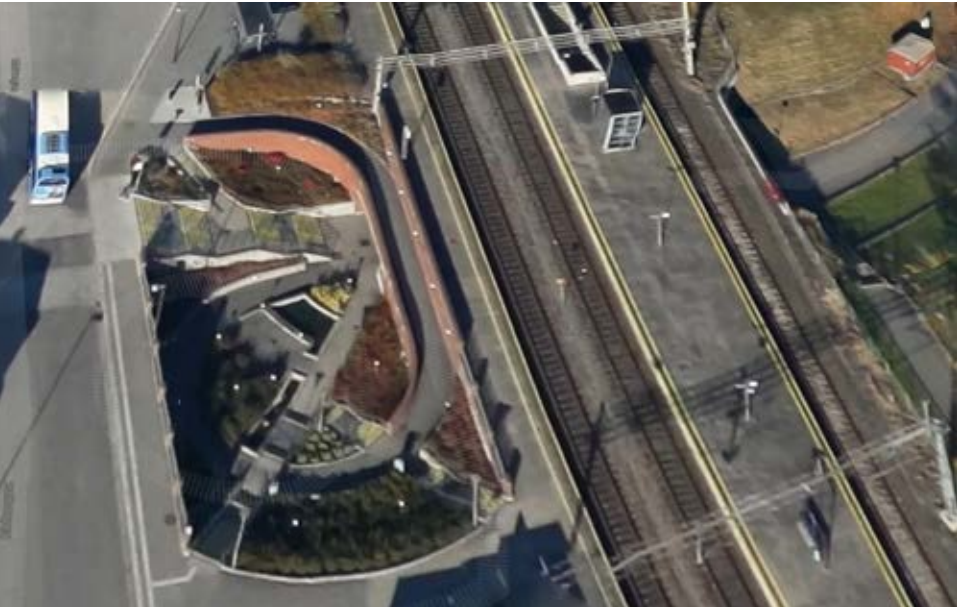
Kulvert under jernbane og rampe, trapper og grøntanlegg ved Rådhusgata, Porsgrunn. (Kilde: google.no/maps)
