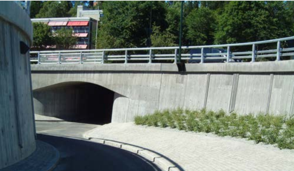
Kulvert i Billingstadsletta har avrundet form på åpning og har bankett som gir god sikt for syklistene.
