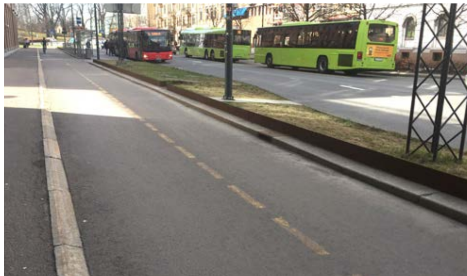
Munkedamsveien bruker cortenstål som kant og tilsås med gress som rabatt langs veien. Rabatten deler de myke trafikkantene fra biltrafikk og bruker som tydelig ledelinje for trafikken.
