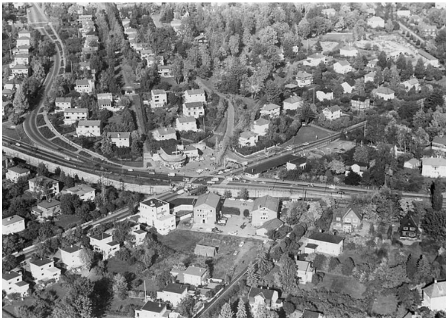
Smestadkrysset med bebyggelsen langs Gjøaveien og Viggo Hansteens vei øverst til høyre (Widerøes flyveselskap, 1971, Oslo Byarkiv).
