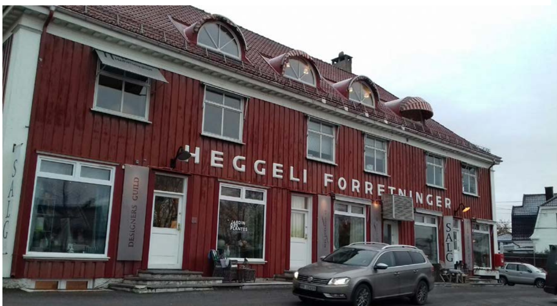
Heggeli forretninger, Heggelibakken 2 (Byantikvaren, 2017).
