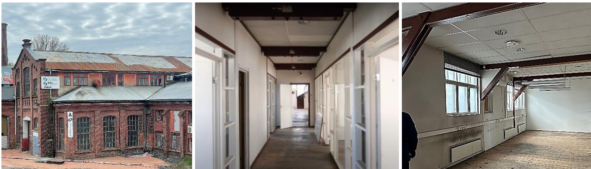
Illustrasjon 58, 59 og 60 Fra nordøst ses plan 3 som rager høyest opp, med fasade over tilstøtende takflater. Interiør fra midtkorridor mot øst. Typisk areal med høysittende vinduer. Atelier Oslo og Ronny Boysen.
