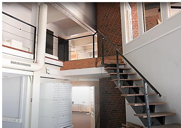
Illustrasjon 51 og 52 Typiske situasjoner i de tilfeldig bygde kontorarealene med usikre trapper og dekker som treffer midt på vinduene. Uklare romforløp og kommunikasjonsveier, Atelier Oslo og Ronny Boysen.
