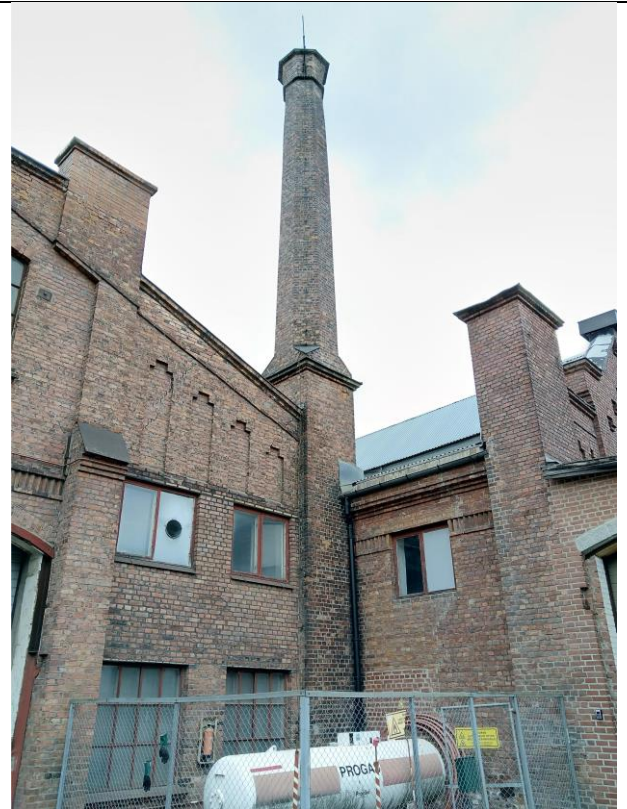
271: Skorstein mellom takflate T3-42 og T4-41 mot øst.
