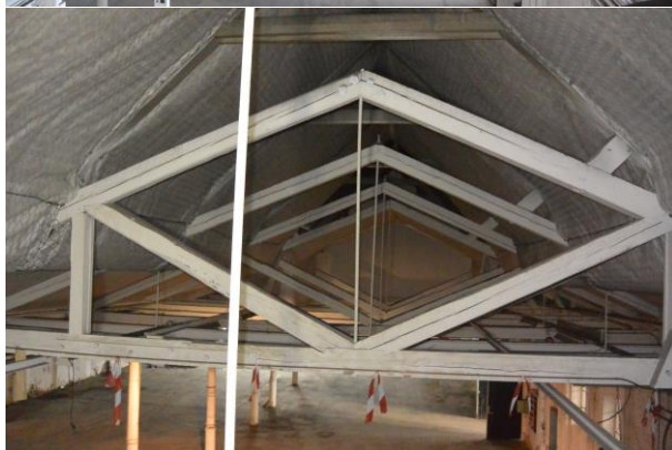
261-1.1/261-1.2: Tretakstoler, hhv. rom S4-1301 og S4-1303.
