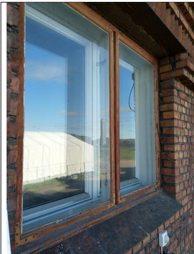
234-2: Trevindu, fasade vest 5.
