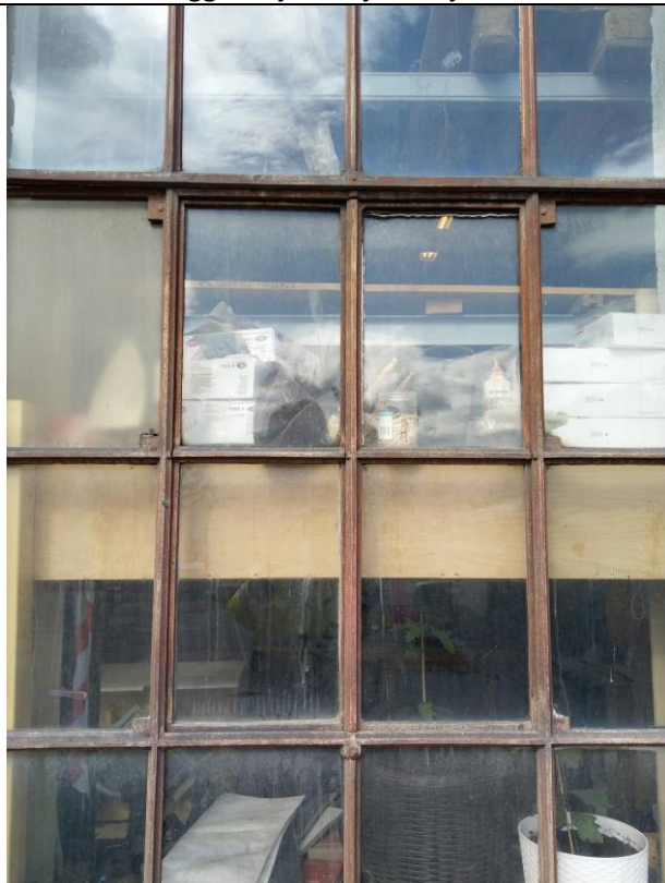
234-1: Støpejernsvinduer, fasade øst 1.
