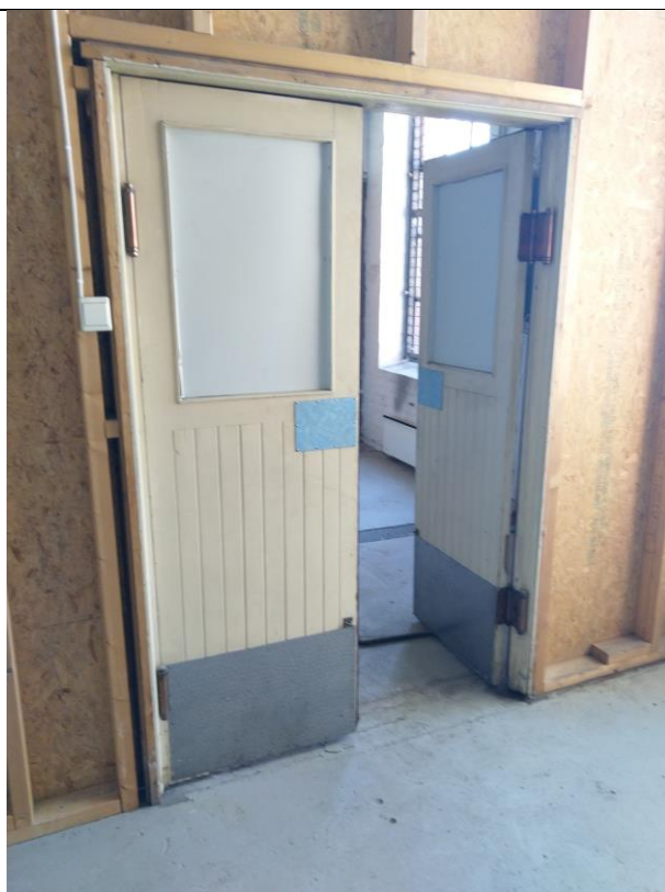
244: Innvendig vinduer, dører og foldevegger, rom S4-1103.
