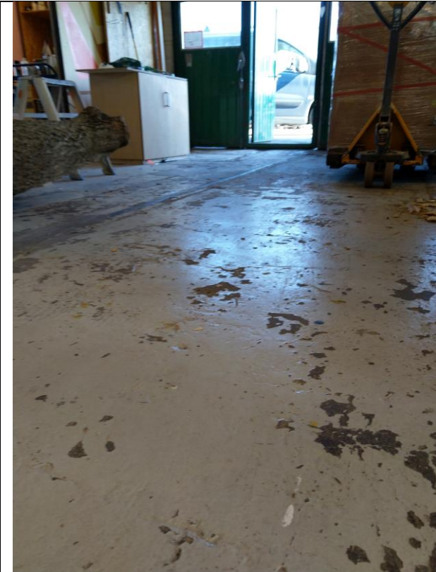
252: Gulv på grunn, støpt dekke, rom S6-1101.
