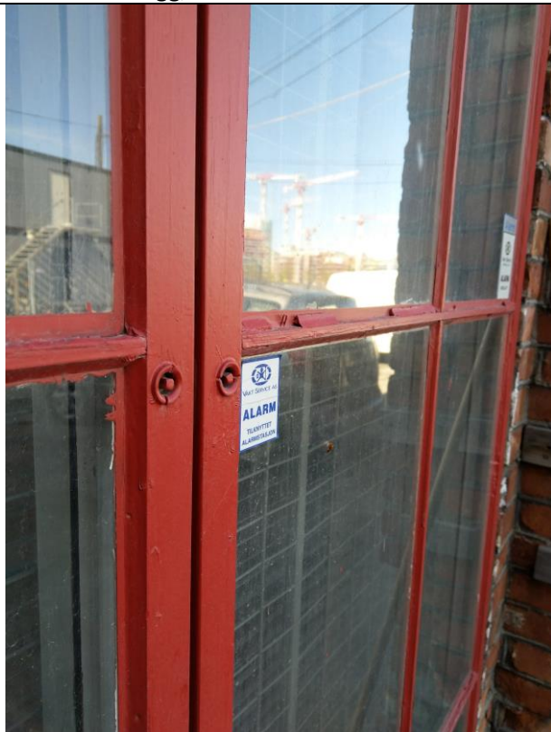
233: Glassfasade, fasade nord 1.
