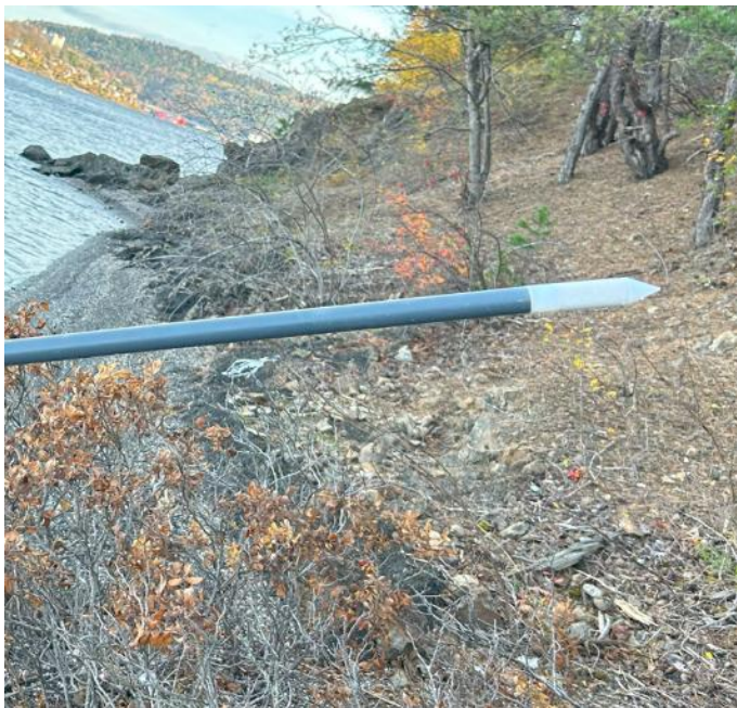
Figur 26 Vakuumsonden (hvit) som skal presses inn i massene. Slangen til sonden ligger inne i det grå røret. Hullet sonden presses inn i ble laget med metallstanga (COWI)
