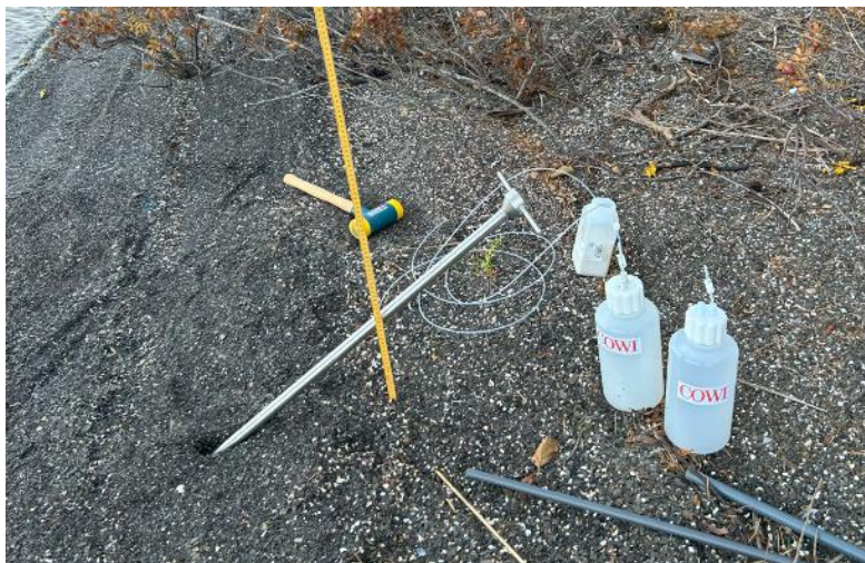
Figur 27. Bildet viser installering av vakuumsone 1 på Rambergøya i oktober 2024 (COWI).
