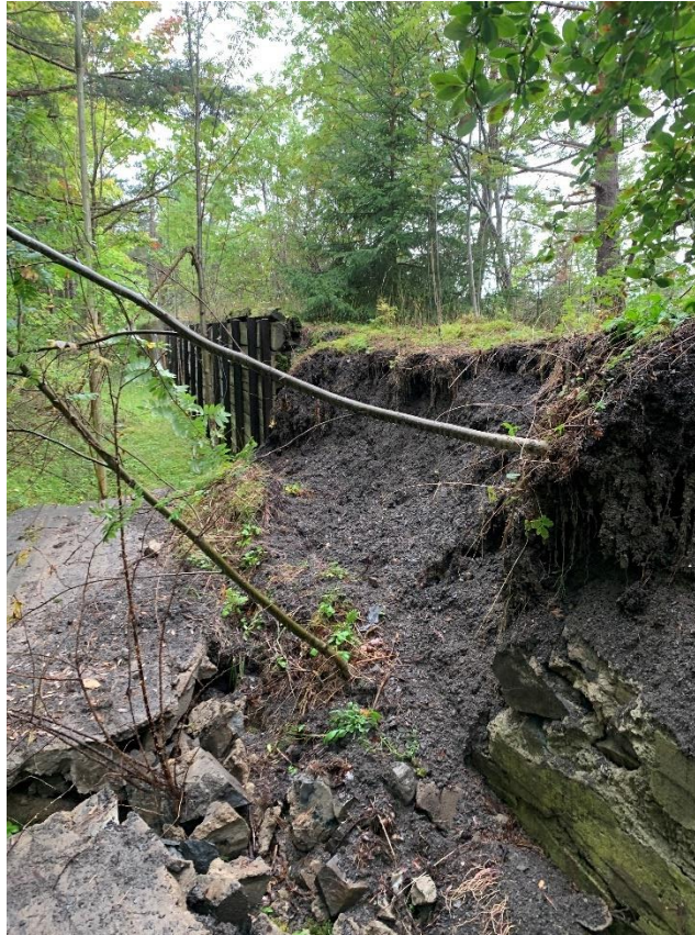
Figur 10: Prøvetakingspunkt RN1, deler av skivevollen til antatt 275-meters bane har rast ut ned i anvisergraven
