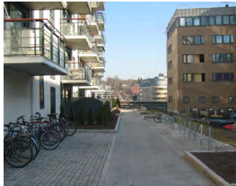
Begynnelse av vei, samt felt foran inngang bør ha avvikende belegg; her godt eksempel på bruk av klare overganger markert med ulik markdekke. Foto Husbanken.
