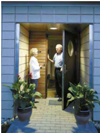
Eksempel på godt belyst inngangsparti. Her innebygd taklampe med 11W kompaktlysrør. Foto: Husbanken
