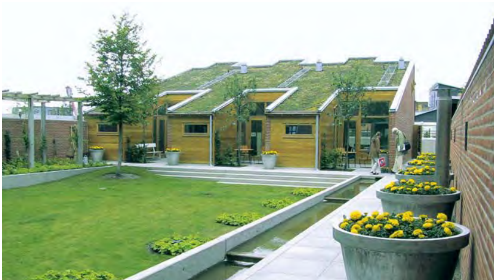
Takhage fra Bo 01 Västra Hamnen, Malmö
