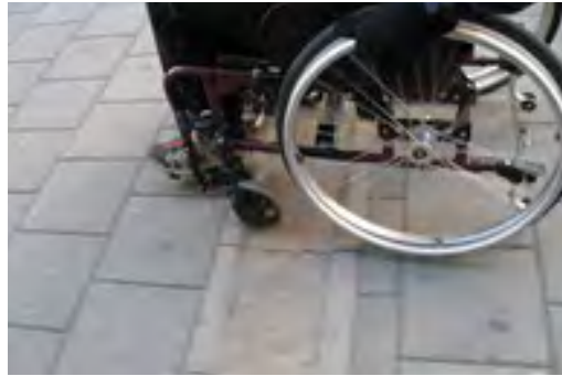
Bruk av brede vannrenner som er avrundet er lettere for mindre hjul å rulle over. Foto Samferdselsetaten.
