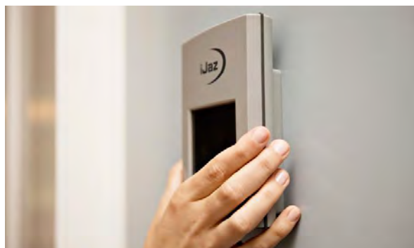
Styring av varme og lys i bygningen via skjerm på veggen. ( http://hjemme.enova.no )
