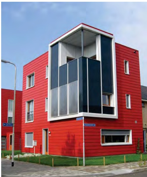
Solceller på fasader i passivhus, Roosendal i Nederland. Kilde: SINTEF Byggforsk
