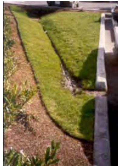
Seattle Overvannet ledes via en åpning i kantsteinen ut på en gresskledd senkning. Eventuelle forurensninger i overvannet filtreres i gressmatten og slammet blir igjen. Renset overskuddsvann renner til sluk/ledningsnett – Thorolfsson (1998)
