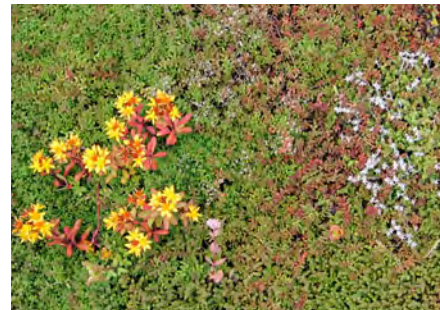
Sedumtak (sukkulenter) har stor absorpsjonsevne og fordrøyer effektivt.
