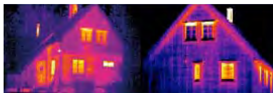
Termografi avslører hvor varmetapet er størst. ( http://hjemme.enova.no )
