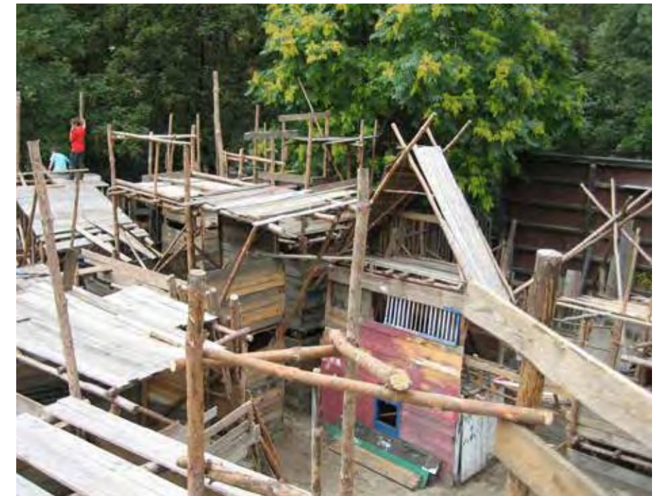
Kolle 37. Byggelekeplass i Tyskland.
