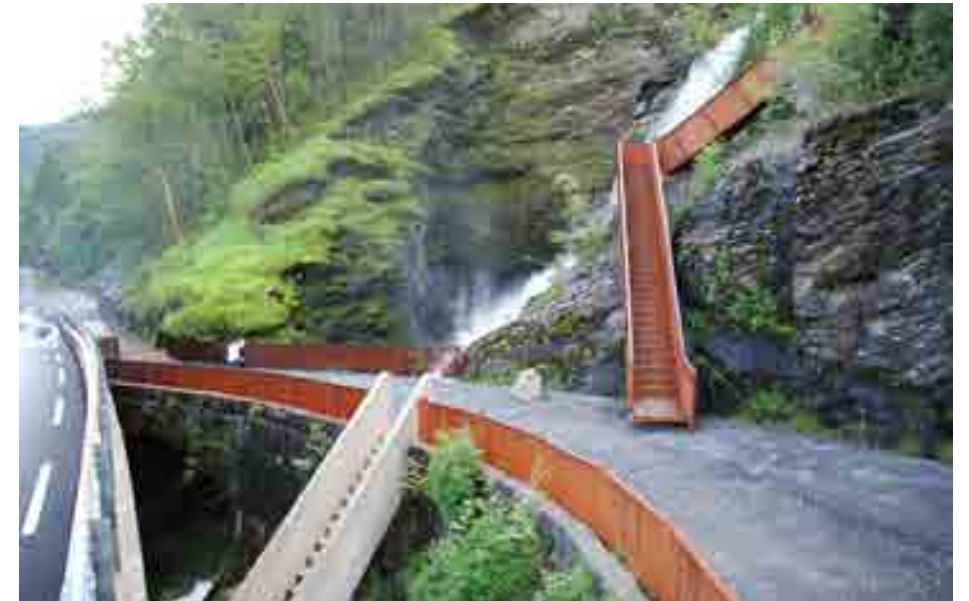
Eksempel på trapp og bro. Svandalsfossen. Av Haga & Grov AS
