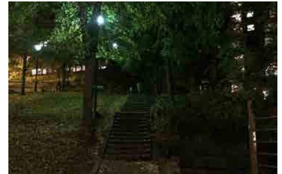
Lyssetting av hovedgangtrapp er ikke i henhold til dagens forskrift!
