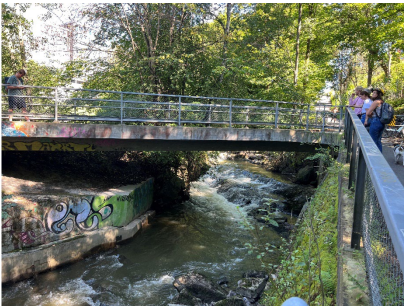
Figur 5-2: Bildet til høyre viser støpt og steinsatt landkar ved dagens bru, som fungerer som barriere og hinder for mulig etablering av kantvegetasjon langs elvebredden; Bildet til høyre viser fossen som er synlig kun fra terrassen ved hovedinngangen til Vegdirektoratet
