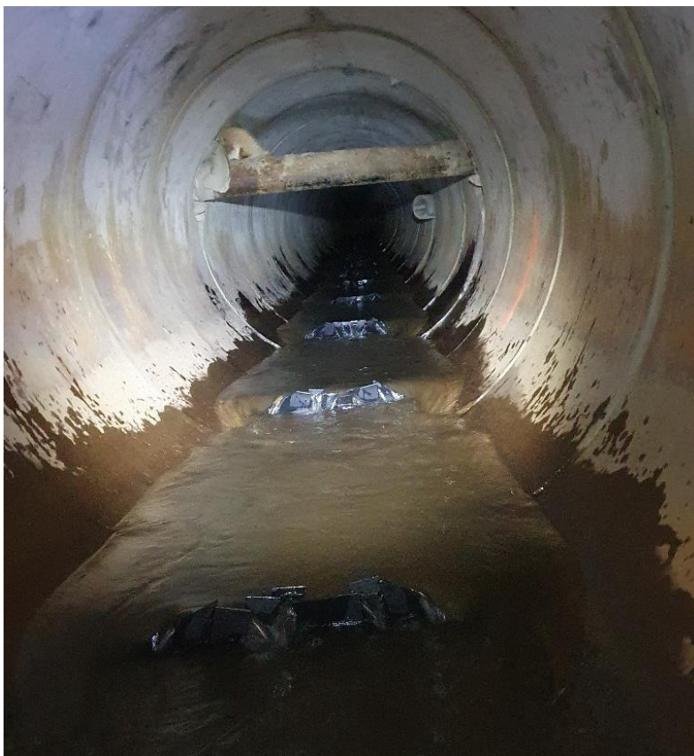
Figur 3-2. Baffles (plastterskler) montert i bunnen av en eksisterende kulvert. Bilde hentet fra et prosjekt i Moss.
