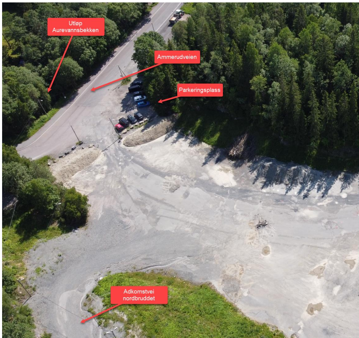
Figur 2-10. Dronebilde fra befaring 30.06.2022. Ammerudveien, parkeringsplassen, adkomstveien til nordbruddet og utløpet til Aurevannsbekken er markert.
