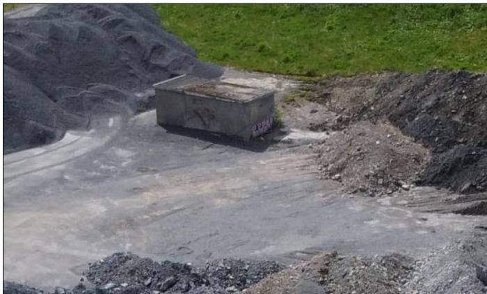
Figur 2-12. Dronebilde fra 2022 som viser eksisterende trafo 3037.
