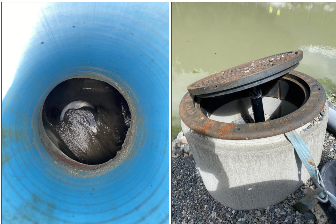
Figur 2-7. Bildet til venstre viser det som ser ut til å være en kum med y-løp, og antas å være kum K4 iht. Figur 2-6. Det antas at dette er kummen hvor drengsledningene som ble etablert som en del av overvannshåndteringen for pukkverket samles. Bildet til høyre viser en kum hvor det er etablert en stengeventil, og antas å være kum K5 iht. Figur 2-6. Det antas at dette er kummen hvor påslippet fra drengsledningene til rensedammen kontrolleres. Bilder tatt på befaring 13.06.2022.
