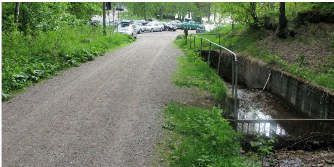
Bildet. Profilet for vannføringsmåling der Skuggenbekken renner ned i kulverten under parkeringsplassen ved Bogstadvannet.
