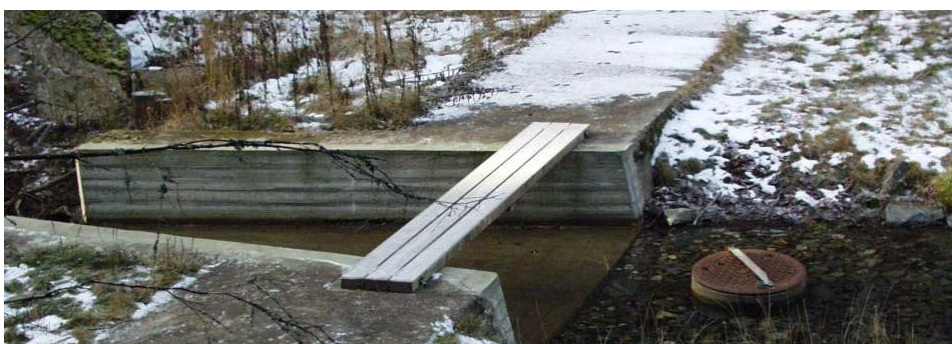
Bildet viser utløpet av Lutvann slik det ble etter rehabiliteringen i 2011 (foto: Vannkilder).
