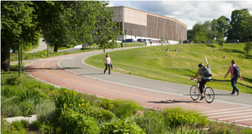
Bilde 4: R1 OG R2 - Seriekoblede regnbed: Overvannet fra gang- og sykkelvei ledes til to seriekoblede regnbed, disse er forbundet ved at drens vann og utløp fra det ene ledes via rør til det andre for videre fordøyning og infiltrasjon. Foto: Asplan Viak / Kirsti Reinsberg Mørch
