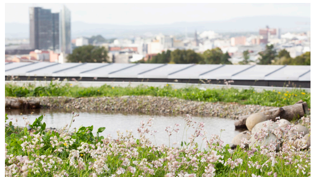
Bilde 2: Vann for økt biodiversitet: Ved større nedbørsmengder blir overvann tilgjengelig, stående i lokale forsengkninger på taket, framfor at alt fordryes i substrat og vegetasjon. Foto: Asplan Viak / Kirsti Reinsberg Mørch
