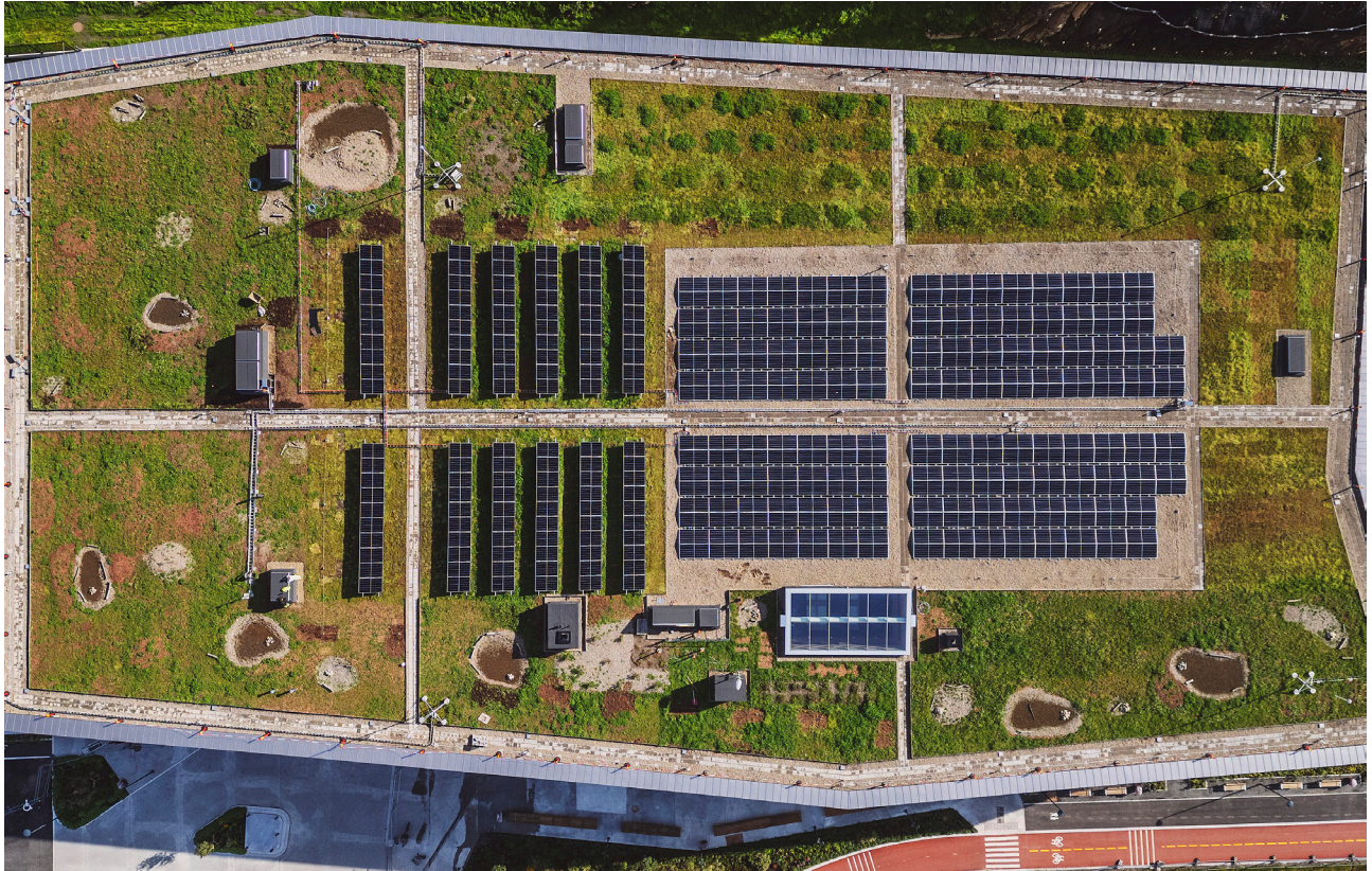
Bilde 3: Blågrønn innovasjon: Med rundt 1000 m 2 solceller og en beplantet flate på 3 650 m 2 , bidrar Tøyenbadets tak både til energiproduksjon og styrking av biologisk mangfold. I takområdene med størst lastekapasitet i nord og vest, er det etablert tykkere vekstmedium med lokale forsengkninger, steiner, trestokker (død ved) og høyere vegetasjon, mens sedum med tørreng i lokale forhøyninger er etablert i som ekstensivt og semi-ekstensivt grønt tak i øst. Dronefoto: Asplan Viak / Jostein Thorvaldsen
