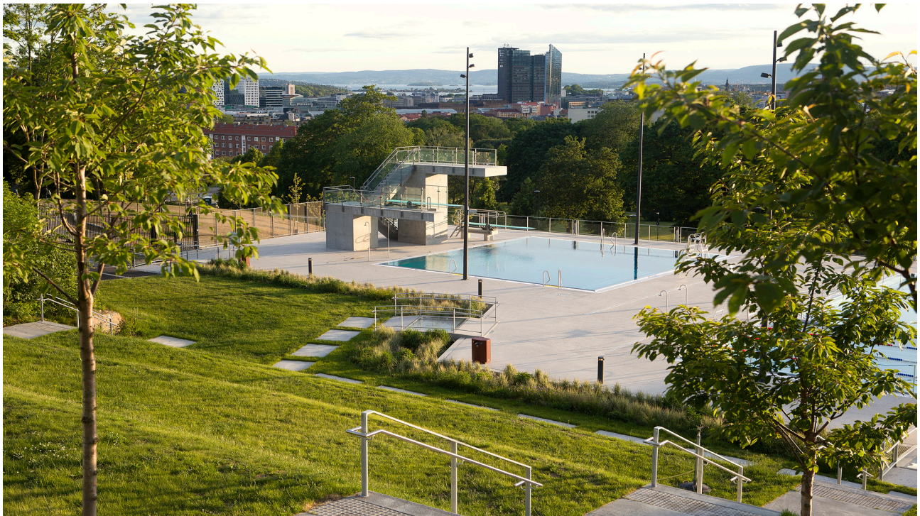
Bilde 7: Regnbed langs plasstøpt dekke: I utebadområdet ledes overvannet fra de plasstøpte betongdekkene ned i langsgående regnbed mellom gressplen og dekke. Regnbedene er gjennomgående, og de badende krysser via små gangbroer med fotbad. Foto: Asplan Viak / Kirsti Reinsberg Mørch
