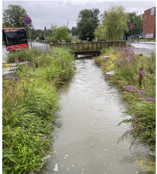
Bilde 6: Frodig bekk i tett by. Ved styrtregn fungerer bekken som flomvei. Foto: Tharan Fergus
