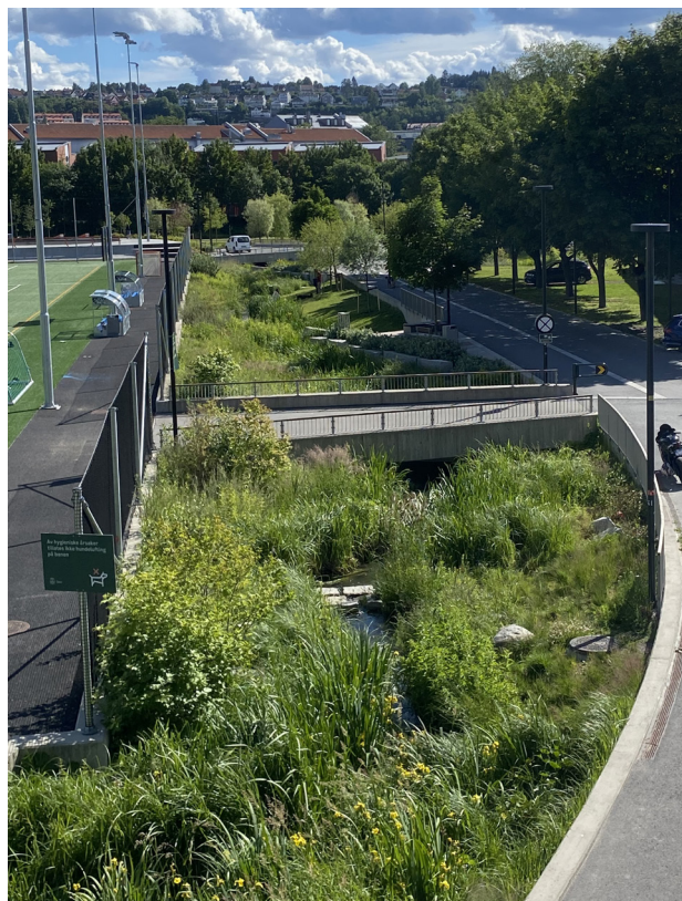
Bilde 3: Bekken med frodig vegetasjon. Hovinbekken søker å etterligne en naturlig bekk, med tett vegetasjon. Vannet strømmer over membraner for å unngå vanntap, det betyr at den ikke er i kontakt med grunnvannet. Foto: Tharan Fergus
