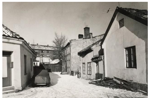
I mars 1965 så det slik ut ved Maridalsveien 14. Til høyre gavlen på Vinger-stuen i Sagveien 16. (Foto: Byantikvaren).
