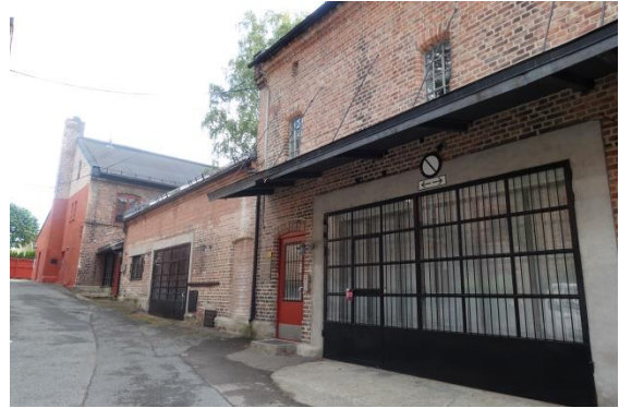
Verkstedbygningen i 2020. De store gitterportene er av nyere dato, og var ikke satt opp på fabrikkens tid.
