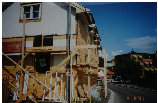
Sagveien 16 settes i stand i august 1997, og Byantikvaren dokumenterer arbeidet. Forfallet var prekært, foto før istandsetting kan sees i vedlegget på nr. 59 Sagveien 16. (Foto: Byantikvaren).
