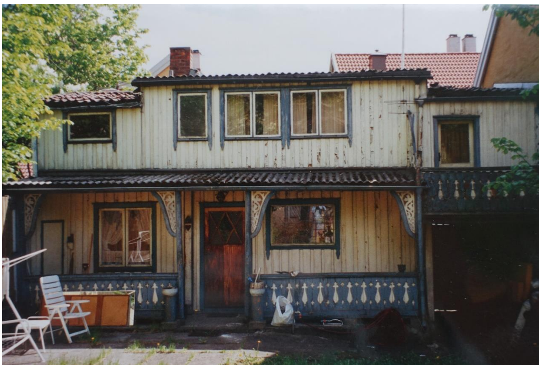
I 1994 så det slik ut i Maridalsveien 76. Det øverste bildet viser uthuset, det andre hovedhusets bakside. Senere ble begge bygningene satt i stand. (Foto: Byantikvaren).
