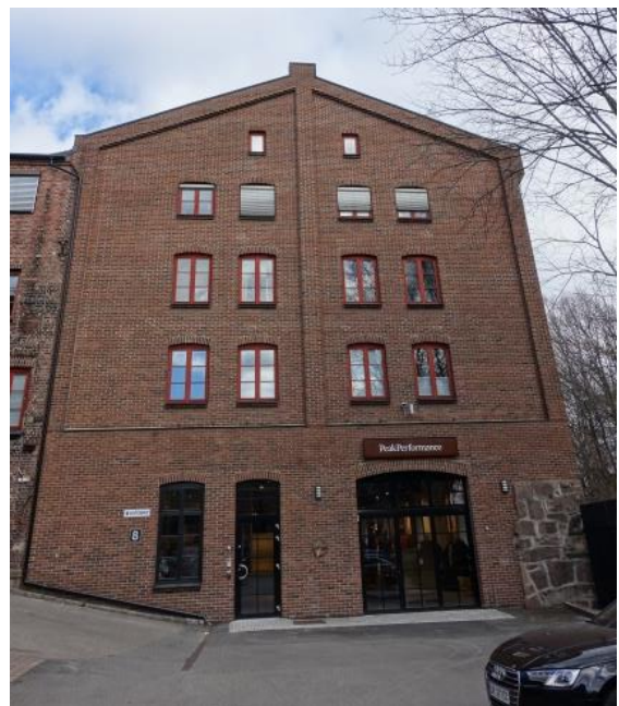
På nybyggets ene fasade er det hengt opp en plakett der det står følgende: «År 1984 ble eieren belønnet for sin omsorg for dette hus. Aftenposten og foreningen til Norges Fortidsminnesmerker bevaring».
