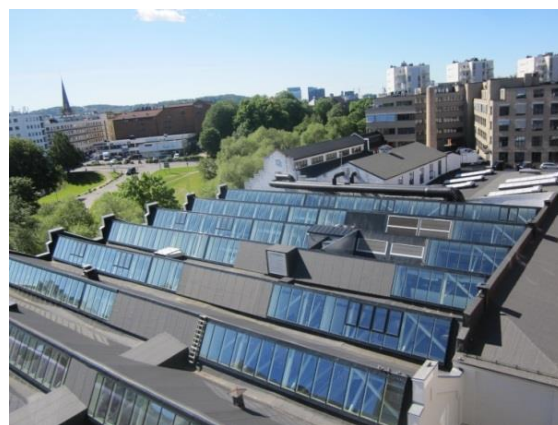
Det karakteristiske shedtaket i den tidligere veverisalen sett ovenfra.
