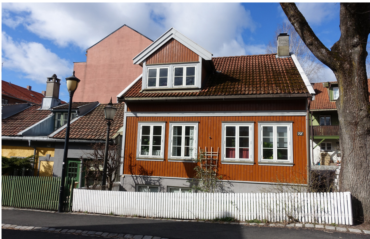
Maridalsveien 72B, et av mange fine eksempler på tilpassede, nybygde trehus i Sagene kulturmiljø. Bak skimter vi svalgangshuset i Maridalsveien 74 B, C og D. Begge bygningene er oppført i 1983. Til venstre ser vi Maridalsveien 70, antagelig oppført rundt 1700. (Foto: Byantikvaren).
