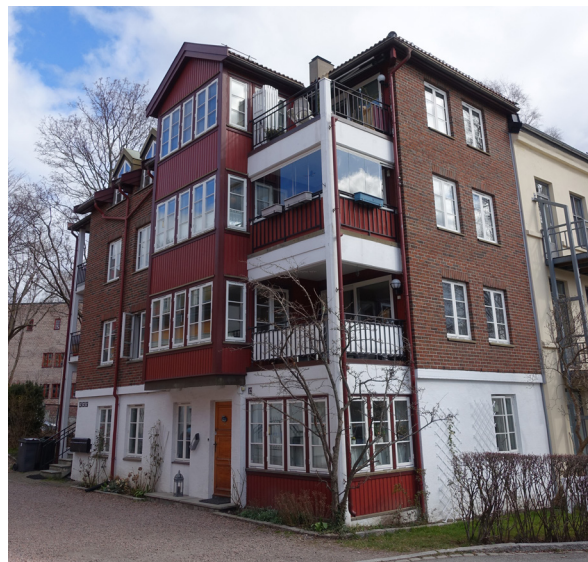
Boligblokken i Våghalsen 12 fra 1983 er tilpasset murgården ved siden av, og har samtidig et spennende og variert arkitektonisk uttrykk. (Foto: Byantikvaren).
