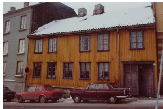
Maridalsveien 58 i 1981, før den ble rustet opp (Foto: Byantikvaren).
