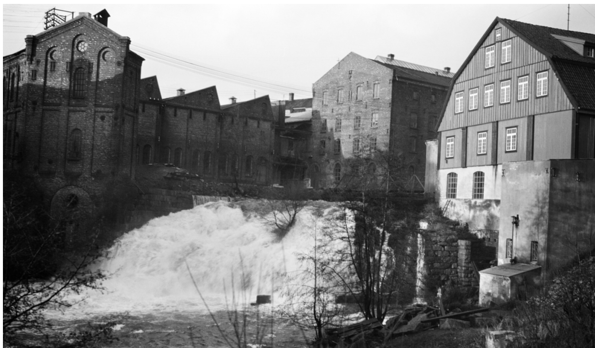
Glads Mølle til høyre, og Hjula Væveri. Industrien lå tett langs elva. Bildet er tatt ca. 1929. På dette tidspunktet var Møllebygningen overtatt av veveriet, som blant annet brukte kjelleren som kraftstasjon. Bygningen har imidlertid vært nærmest uendret siden oppførelsesåret, og det er lett å forestille seg mølledriften her. (Foto: Inger Munch/Oslo Museum).
