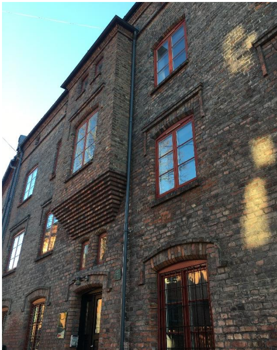
Pakkhuset som ble arbeiderbolig, i Sagveien 23D. Legg merke til karnappet midt på fasaden, og de fine detaljene i muren.
