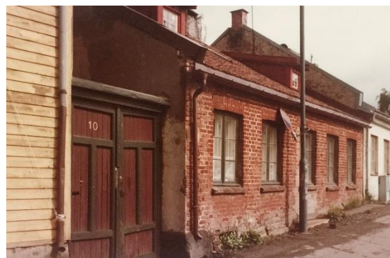
Sagveien 10 i mai 1983. Bygningen har ikke forandret seg så mye, men naboen, nr.8, har blitt rustet opp. (Foto: Byantikvaren).
