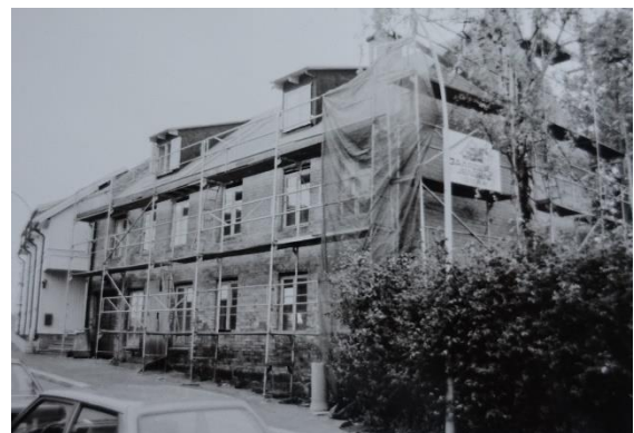
Sagveien 18 under rehabilitering i 1988. (Foto: Byantikvaren).
