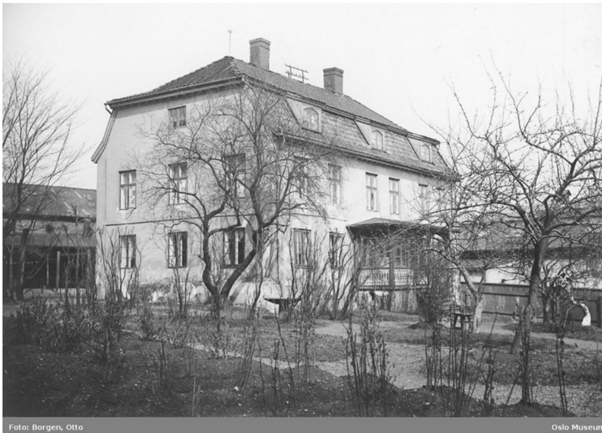
Hovedhuset på Nedre Vøyen gård fotografert i 1915. Det ser ut som et murhus, men er egentlig bygget i bindingsverk og deretter kledd med murpuss. Legg merke til den store hagen.
