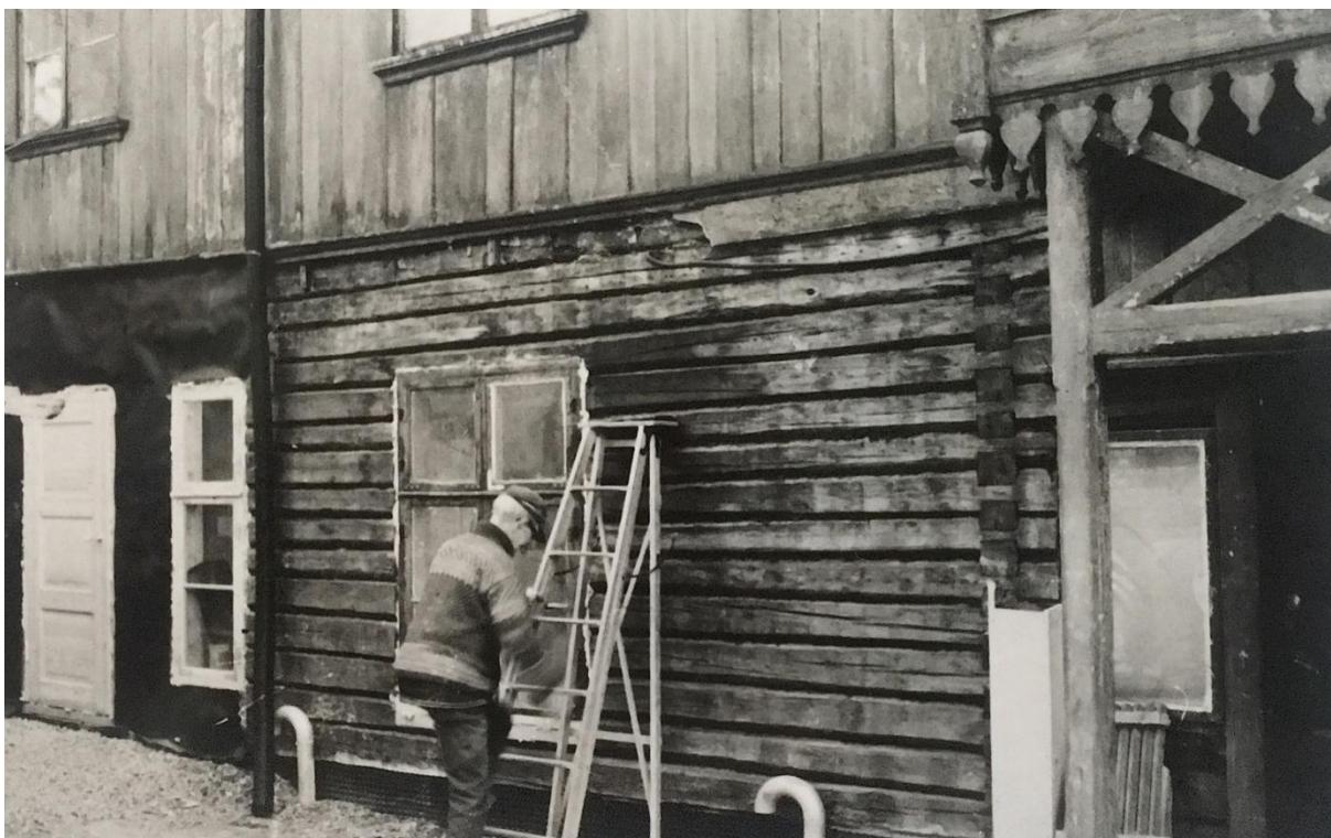
I september 1974 var rehabiliteringen av Sagveien 26 i gang. Byantikvaren var med på prosessen. (Foto: Byantikvaren).
