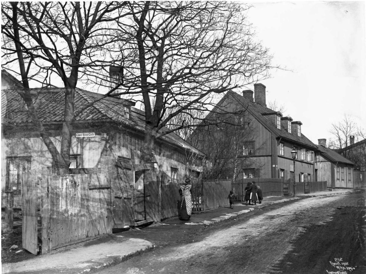
Trehusbebyggelse i Maridalsveien 70-76. Her kan vi se Maridalsveien 70 (nederst til venstre) før det fikk murpuss lagt utenpå trepanelet. Legg merke de typiske hagegjerdene, som det var og er tradisjon for her i strøket. Foto fra 1902. (Foto: Anders Beer Wilse/Oslo Byarkiv).
