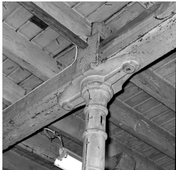
Hjula Væveri: Detalj av jernsøyle som bærer bjelketaket i sydfloyens første etasje. Søylen fra etasjen over omslutter bjelkelaget og hviler på søylekapitelet. (Foto: Finn Larsen 1977/Norsk Teknisk Museum).
