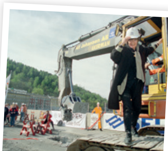
Tidligere miljøvernminister og påtroppende samferdselsminister Sissel Rønbeck satt bak spakene på betongknuseren, da rivinga av Loenga bru i Gamlebyen startet 21. mai 1996. Foto: Arne Ove Bergo, Arbeiderbevegelsens arkiv og bibliotek/Arbeiderbladet AAB-117706
