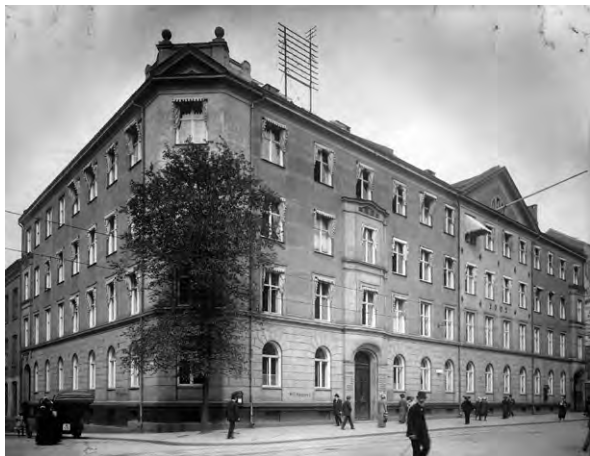
▲ Det store kommunale kontorbygget i Dittenkomplekset i Akersgata 55. Her var Oslo pensjonsinnretning samlokalisert med blant annet Fattigvesenet, Overformynderiet og Kemneren, 1905. Foto: Anders B. Wilse, A-10001/Ua/0011/063
