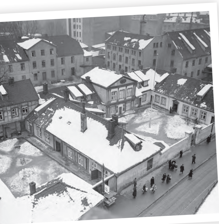
Storgata 36 sett fra luften, januar 1950.
