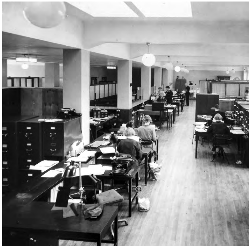
Andre etasje i Dittenkompleksets nybygg fra 1933, hvor Morspensjonen holdt til sammen med Pensjonsinnretningen og Fattigvesenet. Foto: Byarkitekten, fotograf ukjent, A-20031/Ua/0008/006 ►
