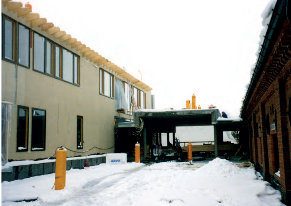
Byarkivets nybygg under oppføring vinteren 1998-1999. To etasjer med kontor- og publikumsarealer ble bygget på toppen av Nora Fabrikkers lagerlokaler i Maridalsveien 3. Foto: Oslo byarkiv 3 A-10001Ua0006_1
