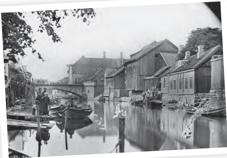
Korleis var lydane inne i fabrikkane og kor høgt ringde stilla i øyra til arbeidarane når alle maskinene brått blei slått av? Fabrikbygningar som speglar seg i Akerseleva, Nydalens Compagnie. A-10093/Ua/0001/200
