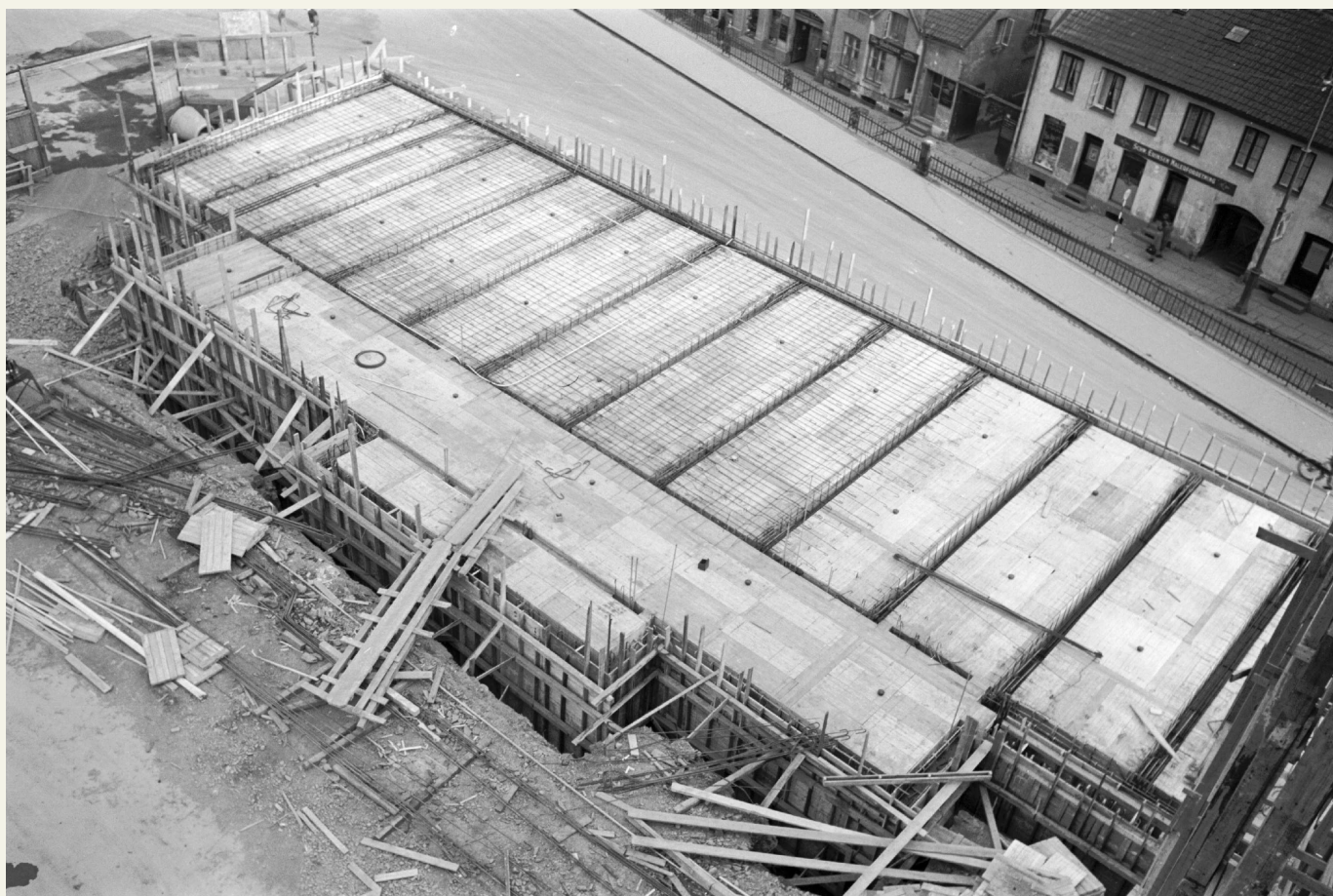
Ruseløkka skole under forskaling og oppføring i 1938. Ukjent fotograf. A-20032/Ua/0006/015
