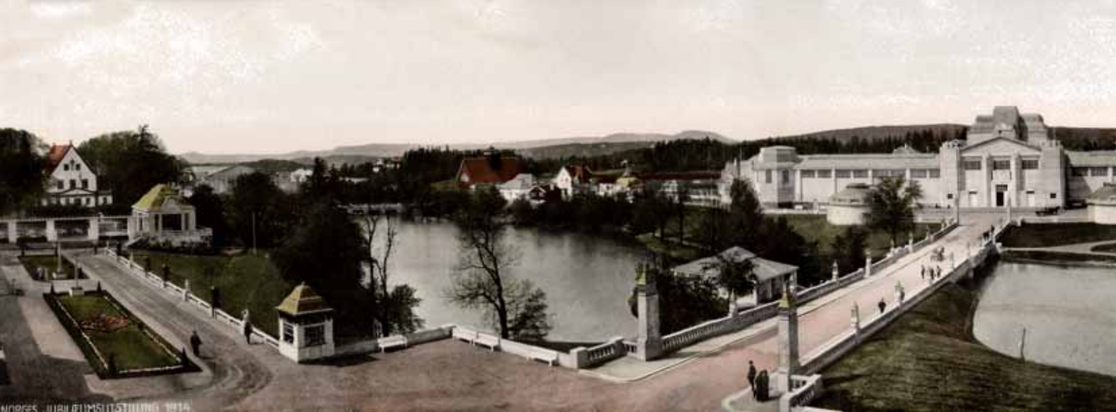
Eventyret på Frogner. Panorama over utstillingsarenaen i Frognerparken. Midt i bildet brua og Industrihallen, til høyre Maskinhallen med sine to tårn. Alle bygningene ble senere revet. Fotografiet ble massedistribuert og fantes i de tusen hjem etter at utstillingen var ferdig.
