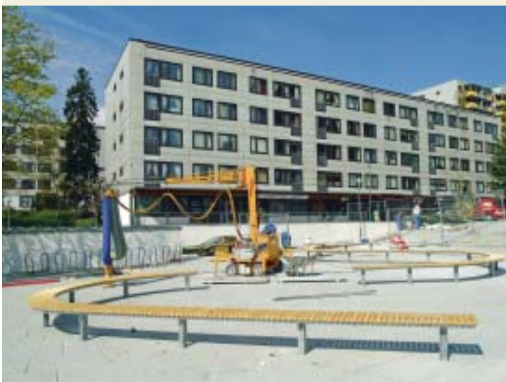
SOM NYTT! Den 10. juni kan du se hvordan sentrumsområdet på Hovseter har blitt.
