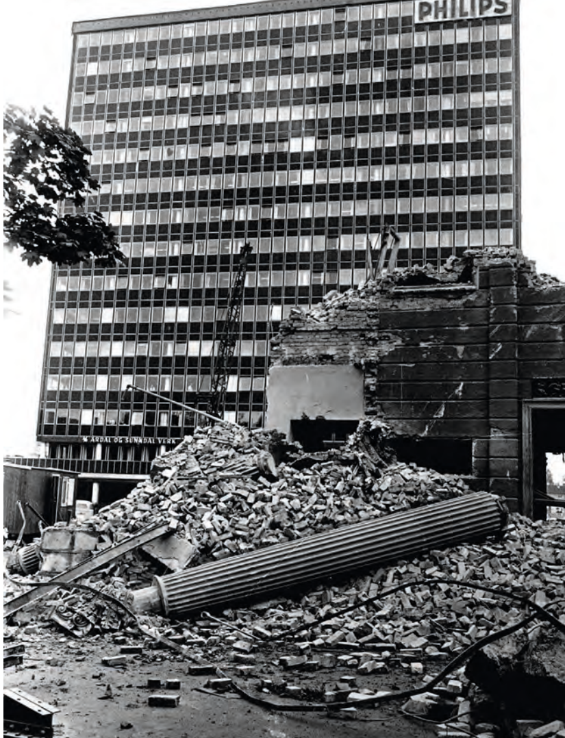
Natt til 20. august 1964 ble Kinopaleet revet. Dagen etter kunne VGs fotograf avfotografere ruinene foran Philips bygget. Det kjente bygget ble revet bare dager før det skulle feire sitt 40-årsjubileum. Foto: NTB Scanpix
