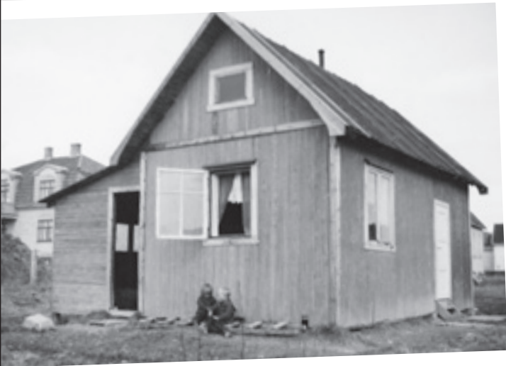
Bolignøden gjorde at mange bodde i brakker og hytter som var trekkfulle og dårlig isolert. Ukjent sted ca. 1930. Foto: Nanna Broch. Oslo Museum OB. F04056a
