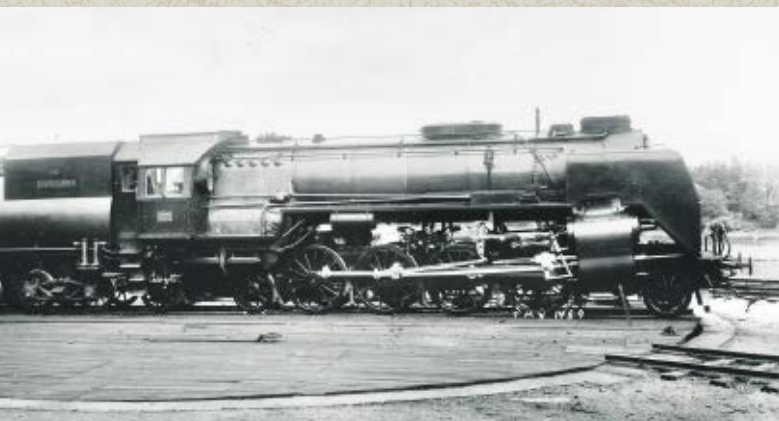
Dovregubben (NSB type 49) var en norsk damplokomotivtype som ble konstruert for å erstatte to lokomotiver med ett til bruk over Dovrefjell. Lokomotivtypen betegner høydepunktet og slutten på norsk damplokomotivproduksjon, Privatarkiv 1817 Thunes Mekaniske Verksted / Thune-Eureka, eske U 22
