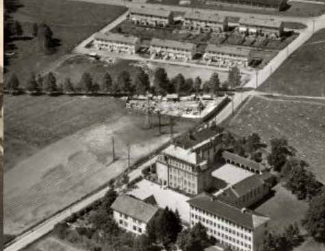
Trangt om plassen: Løren skole sto ferdig i 1891. Bygningen rommet klasserom til de 43 elevene, leilighet til overlærer Trøen og kammer til lærerinnen. Senere kom det flere skolebygg, men barnetallet fortsatte å øke. I 1937 var det mer enn 1400 elever på Løren. Foto: Helge Skappel, Widerøes Flyveselskap AS. A-20027/Ua/0012/204, 1952
